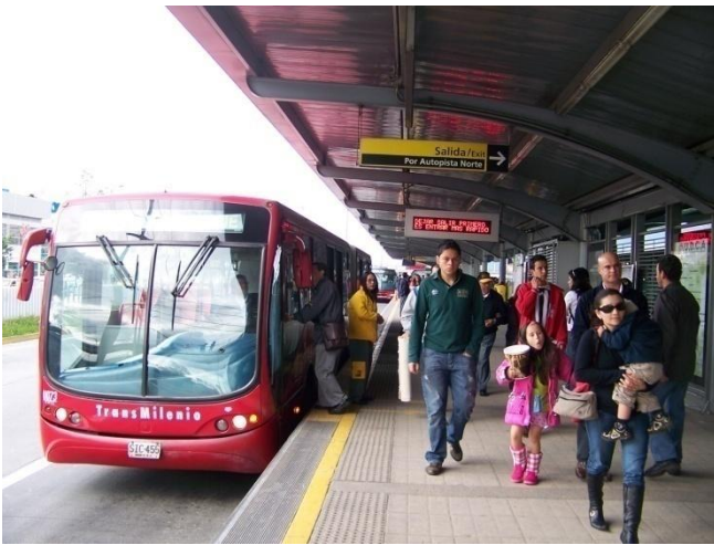
Grafico. Punto de transferencia terminal en la Vía. Plataforma servicios troncales. Portal Norte Sistema Integrado de Transporte Público de Bogotá. 2010
